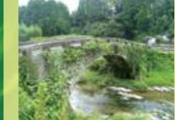
天保2(1831)年、小熊野川に架けられた長さ25m・幅3.6mの石橋。石工たちの技の賜物だ。
